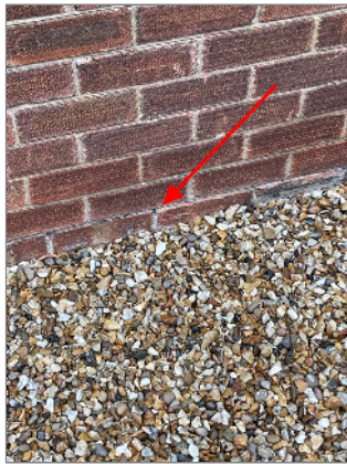
Photo - 33 Bitumen DPC
